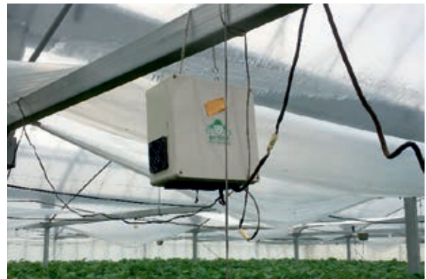
ハウスに取り付けられている「あぐりログ」のセンサー
