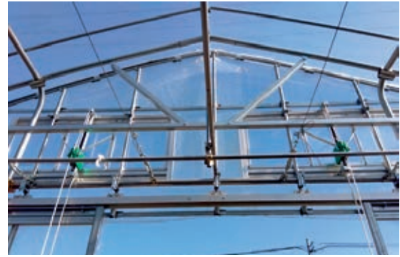
補強入りの耐雪型パイプハウス
